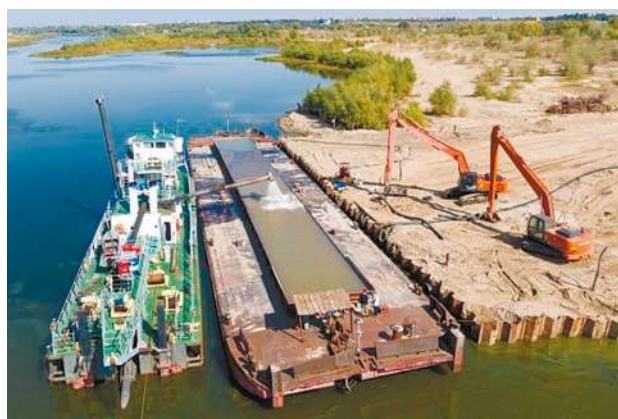
Рис. 4.3 Расчистка русла рукава Ахтуба (подготовительный этап)
