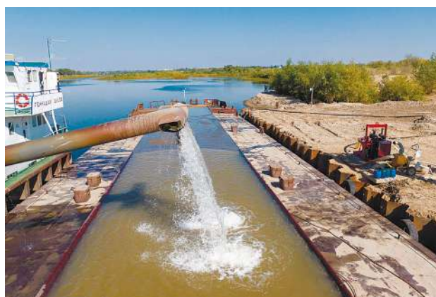
Рис. 4.2 Расчистка русла рукава Ахтуба (подготовительный этап)
